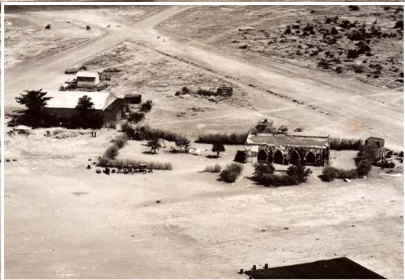
L'aéroport de Niamey en construction.
