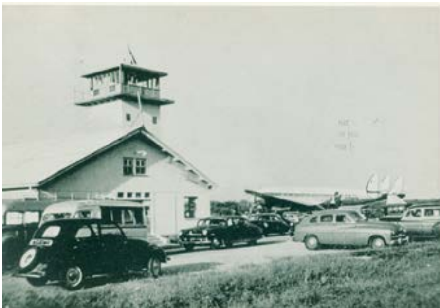
Première tour de contrôle et arrivée du Constellation (décembre 1950).
