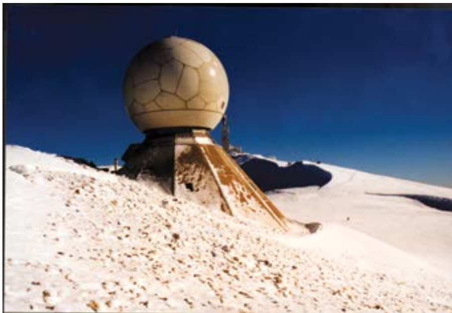
Le radar du Mont Ventoux.
