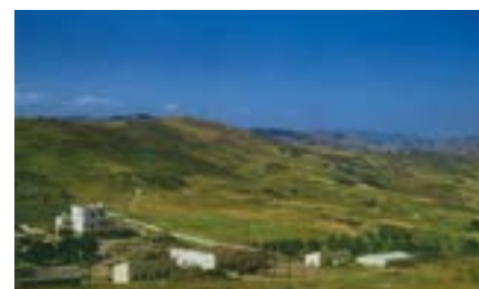
La station météo du col du Touhar.
