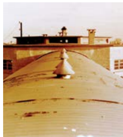
Résidences - toiture du Bloc 111.
